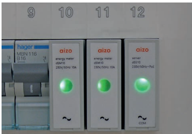
Bild 4 Die Grundelemente in der Elektroverteilung: Der digitalSTROM-Server (rechts) kommuniziert via Internet. Die beiden digitalSTROM-Meter bilden mit den in den Räumen verteilten dSID-Chips die eigentlichen digitalSTROM-Gruppen.
